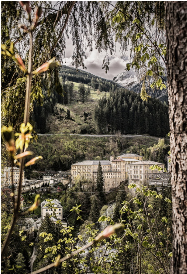
BWM Designers & Architects_BadGastein_Ansicht_Bestand ©_HansSchubert
