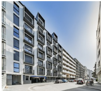
Das Projekt gewann den „gebaut 2020“-Architekturpreis der Stadt.
