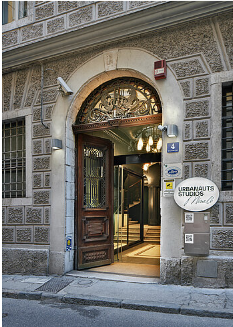
Die Urbanaut Studios Minelli sind in einem historischen Palazzo untergebracht. © Roberto Pastrovicchio
