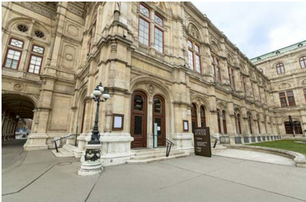
10 ©BWM Architekten_Renée Del Missier
