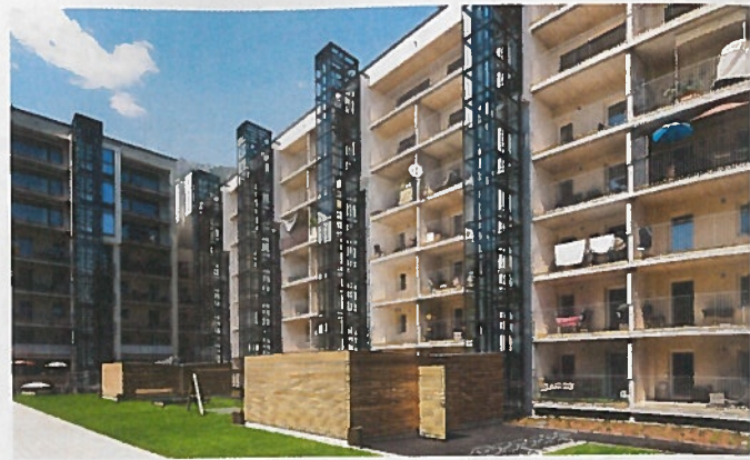
Aus Alt machte Bauträger Neue Heimat Tirol Passivhausstandard: sanierter Altbau mit aufgestocktem Neuba
