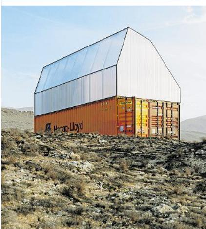
Container als günstiger Wohnraum, hier in Peru. Jede Wohneinheit besteht aus zwei Containern mit einem Dach aus recyceltem Polycarbonat, (Außenaufnahme links), innen mit recycelten Spanplatten ausgekleidet (Bi. re.)
