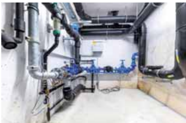
Bildtext: In der Tiefgarage der Am Modenapark 1-3 sind die Mepla Rohrsysteme mit praktischer Presstechnologie sowie die robusten PE Abwasserleitungen für die Haus- und Dachentwässerung zu sehen. Foto: Geberit/Stephan Huger
