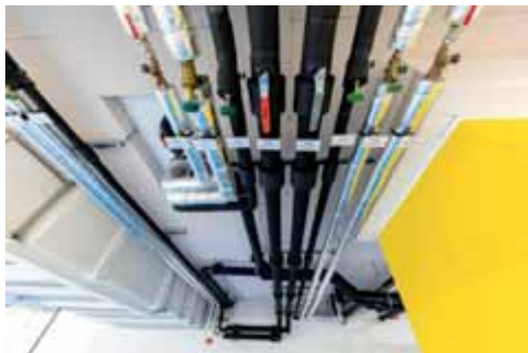
Bildtext: In der Tiefgarage der Am Modenapark 1-3 sind die Mepla Rohrsysteme mit praktischer Presstechnologie sowie die robusten PE Abwasserleitungen für die Haus- und Dachentwässerung zu sehen. Foto: Geberit/Stephan Huger
