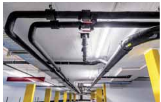
In der Tiefgarage der Am Modenapark 1-3 sind die Mepla Rohrsysteme mit praktischer Presstechnologie sowie die robusten PE Abwasserleitungen für die Haus- und Dachentwässerung zu sehen.
