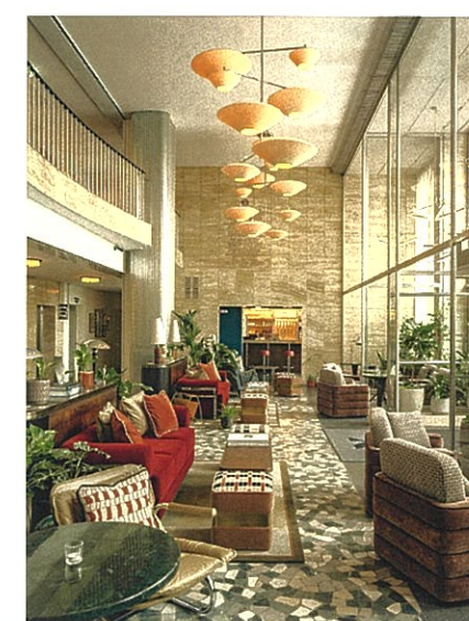
Beim Umbau stellten die Architekten den anfänglichen Zustand des Nachkriegsgebäudes wieder her. Auch in der Lobby Originale: Travertin-verkleidete Wände, Terrazzoböden und Aluminium-ummantelte Säulen.
